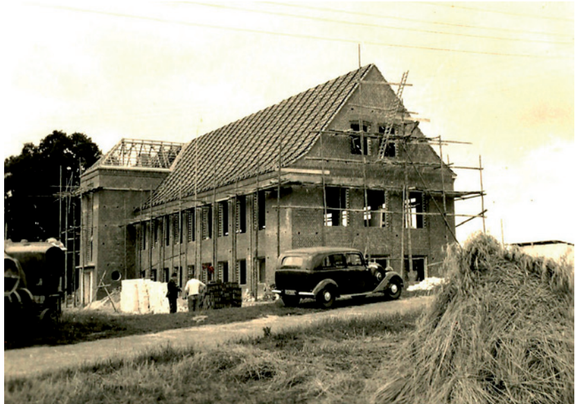
Bahlmann und Leiber Hauptgebäude im Bau, 1949, Jugendherbergsweg
