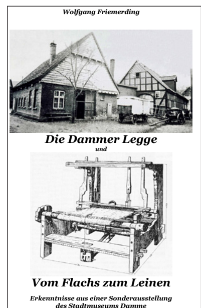
Titelblatt, Abb. (oben) der ehemaligen Dammer Legge als Nebengebäude (rechts) des Stellmachers Josef Nordhoff, Ecke Donau-/Kolpingstr., um 1910 (Foto: Archiv des Stadtmuseums Damme)
