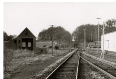
(li.) Lokschuppen der WKB, (re.) Viehrampe, März 1977
