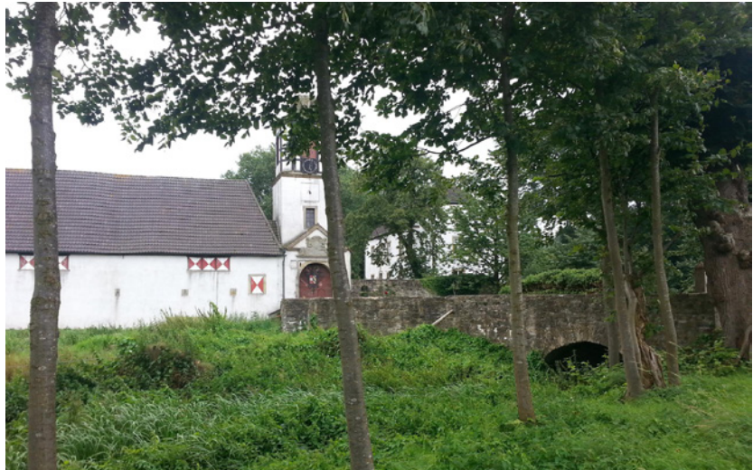
Brückenaufgang zum Wasserschloss Alt-Barenau
