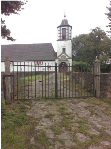
Alt-Barenau vom Brückenzugang gesehen
