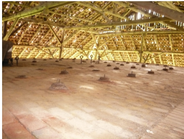
Kohle-Schüttlöcher auf der Decke des Ringofens
