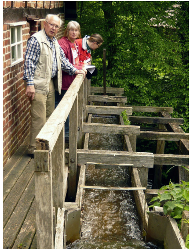
Am Gerinne auf der Wasserradseite der Mühle lässt sich gut erkennen, wie das Mahlwerk mit dem Schwungrad angetrieben wird.
